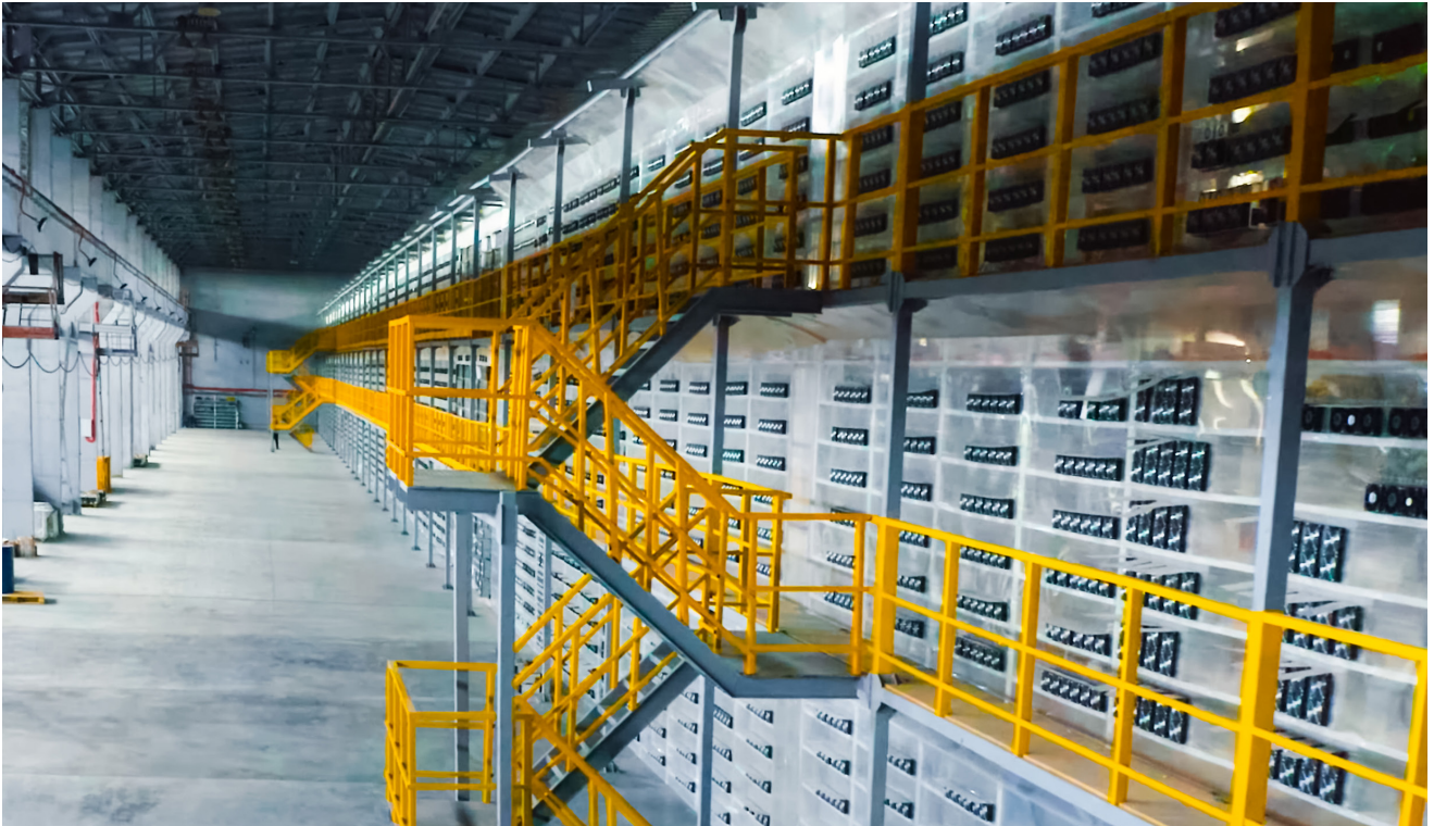
Crypto-Mining-Farm: Die Graphikkarten glühen vornehmlich dort, wo der Strom günstig ist. Der Energieverbrauch der Krypto-Bauernhöfe ist immens. Weltweit gehen konservativen Schätzungen zufolge aktuell 78 Terawatt auf ihr Konto, das entspricht in etwa dem Stromverbrauch Chiles. Bild: hloplex/Shutterstock
